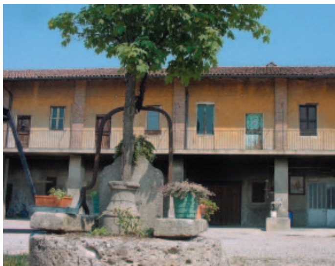
Cascinazza, il porticato e, in primo piano, il pozzo Cascinazza Farmhouse, portico and court with the well
