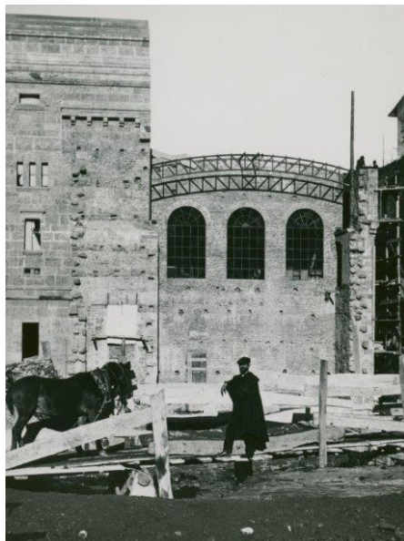
Cantiere della centrale 'Taccani' (Foto Enel Green Power)
