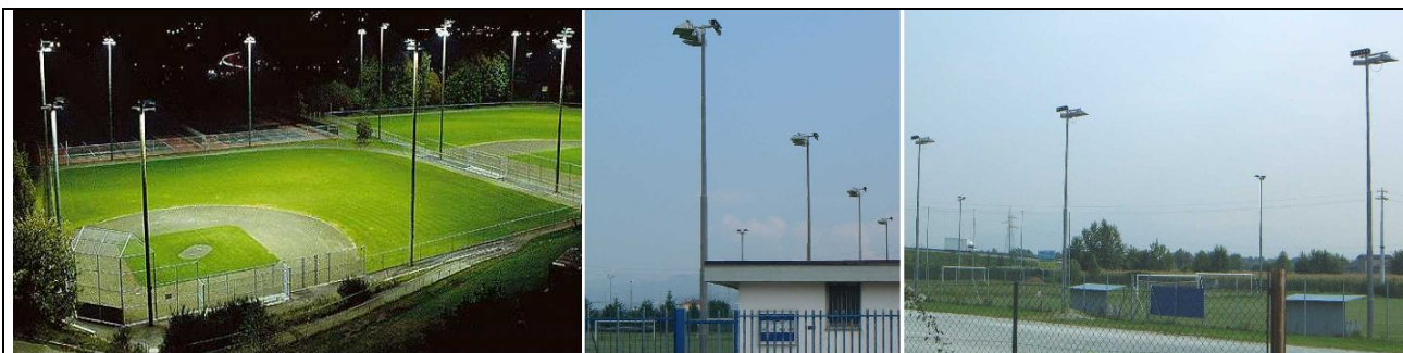
Figura 5.24 - Impianti sportivi illuminati in modo conforme alla L.R.17/00 con proiettori asimmetrici orientati orizzontalmente e che non disperdono luce verso l'alto.
